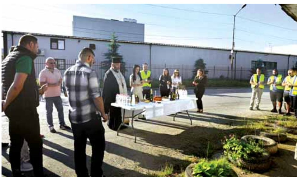
Община Елин Пелин. С водосвет и първа копка стартира проектът „Реконструкция и рехабилитация на водопроводната мрежа на град Елин Пелин – Етап 1“ – на стр. 6
